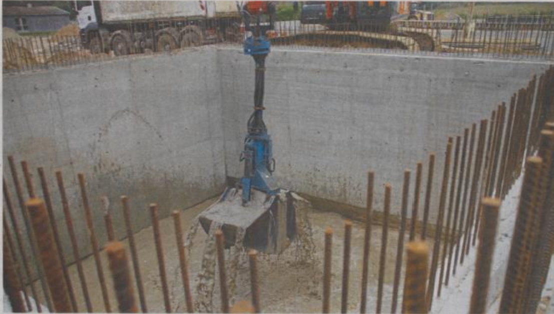
Langsam aber sicher versinkt der Betonquader im Boden. Der Bagger hebt den Boden aus, damit das Bauwerk nachrutschen kann. Das Wasser ist übrigens Grundwasser.
