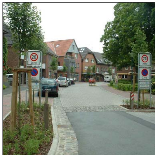
Ausbau nach Fertigstellung
