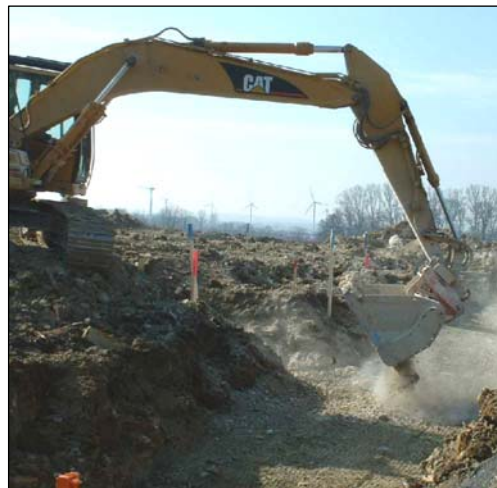
Rohrgrabenverfüllung mit Kalkzusatz mittels Separator
