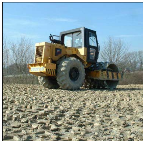
Verdichtung des Lärmschutzwalls mittels einer Schafsfußwalze
