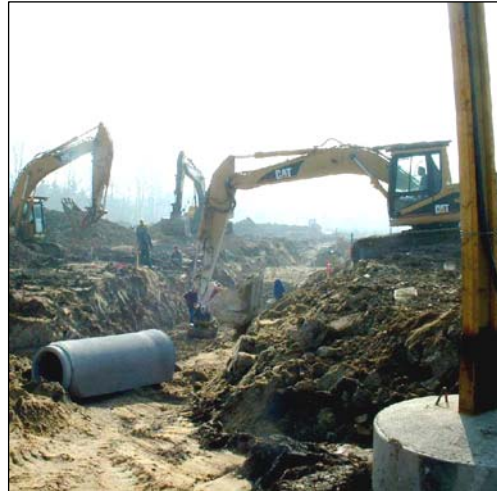
Erdarbeiten im Kanalbau
