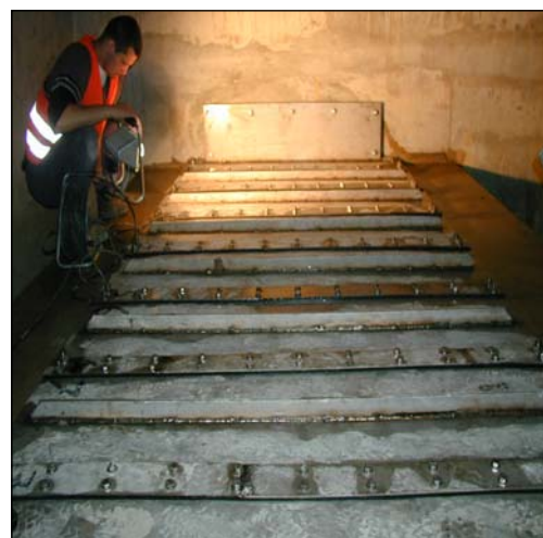
Abdeckung eines Kanals mit Edelstahlplatten
