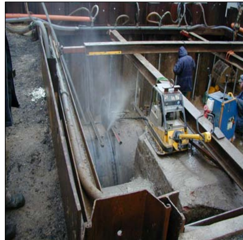
Schneiden eines RW-Kanals DN 2000
